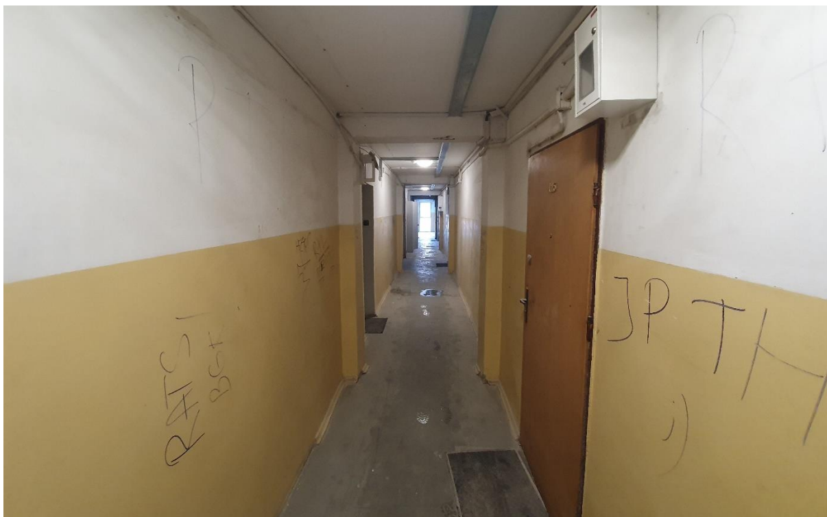
Rysunek nr 6. Widok klatki korytarze na I piętrze w budynku mieszkalnym przy ul. Robotniczej 32.
