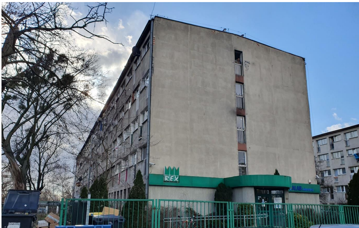
Rysunek nr 5. Widok budynku mieszkalnego przy ul. Robotniczej 32.
